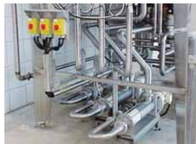
Насосы seepex BCSB 52-6L, продукт: сметана, давление: 4 бар, температура: 5-20°C производительность: 10-40 м³/ч
