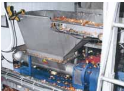
Насос seerex BTM 17-12, установлен в конце контрольного транспортера для размельчения и транспортировки отходов лука, производительность: 8 м 3 /ч
