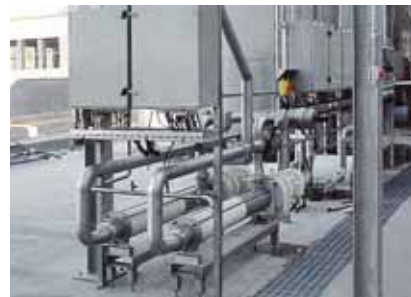
Насос seepex BCSB 52-6L, продукт: джем с цельными фруктами, давление: 4 бар, производительность: 10-20 м³/ч
