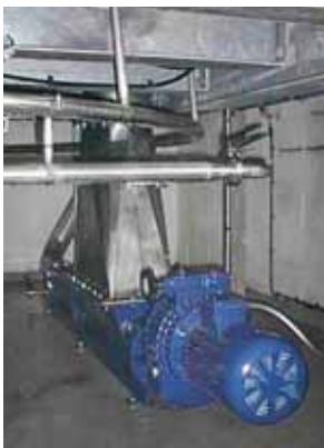
Насос seerex BT 17-12, продукт: затор суслу из заторного котла в фильтрационный чан, давление: 2 бар, производительность: 5 м 3 /ч
