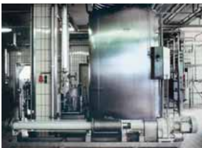
Насос seepex NS 35-24, продукт: фруктовый сок, давление: 24 бар, температура: 65°C производительность: 6-13,5 м³/ч
