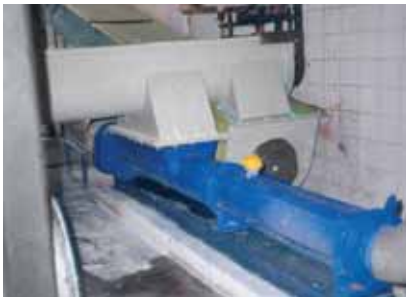
Насос seepex BT 70-6L, продукт: рыбный концентрат для транспортировки в сепаратор, температура: 90°C давление: 2 бар, производительность: 12-22 м³/ч
